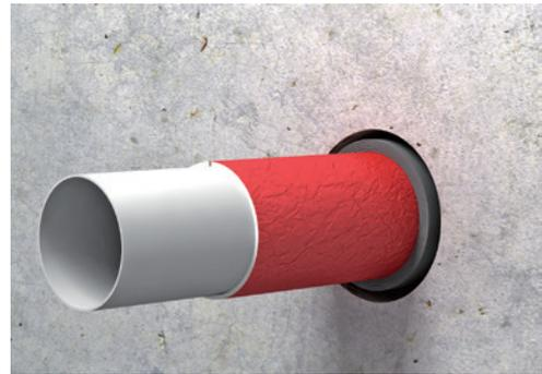
3. Abschließend den Ringspalt um das Rohr im Bauteil mit 1000 Brandschutzkitt, SIBRALIT DX, Mörtel oder Gips gemäß Kapitel 4 verfüllen.
